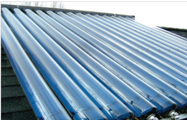
Վակուումացված խողովակավոր արևային ջերմային կոլեկտոր
